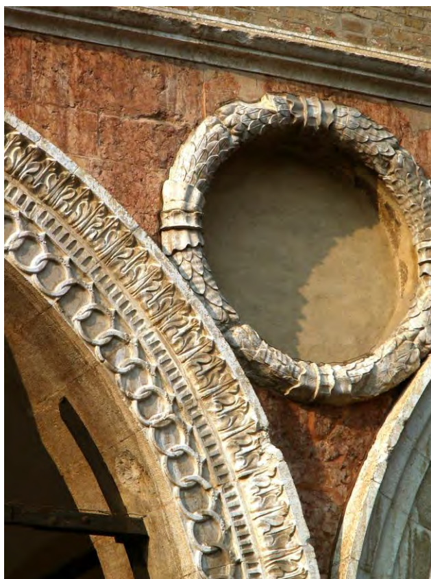
53. Pesaro, arco di ingresso al Palazzo Ducale con la catena di anelli diamantati sforzeschi.
