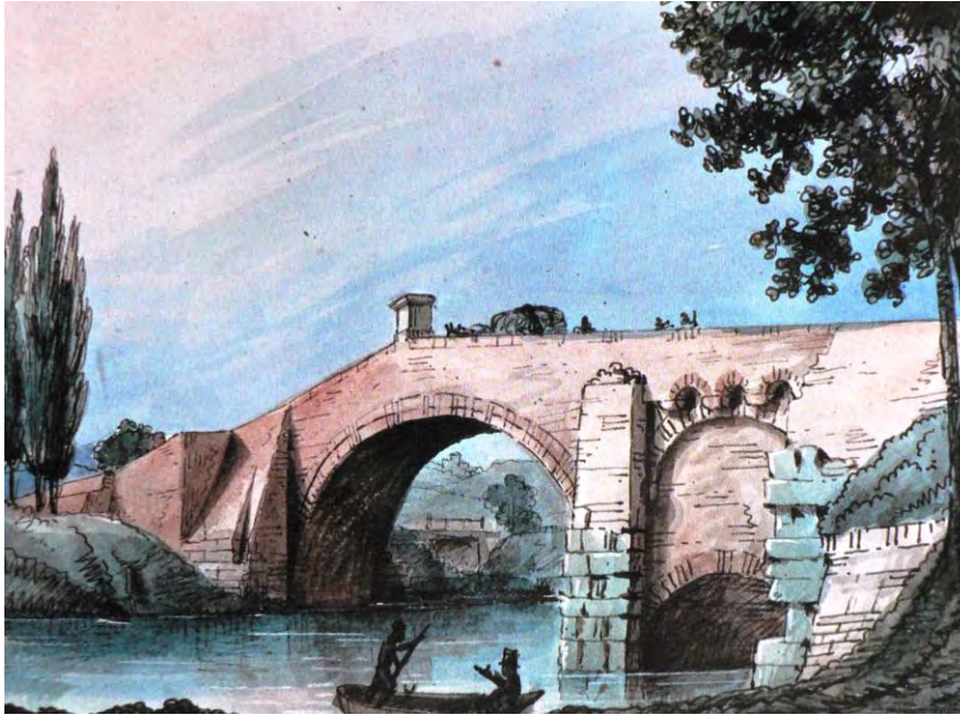
79. Il ponte sul fiume Foglia in un acquerello di Romolo Liverani, attorno al 1850 (Forlì, Biblioteca comunale A. Saffi, Fondo Piancastelli). Sopra l'arco di destra sopravvivevano tre cannoniere circolari.
