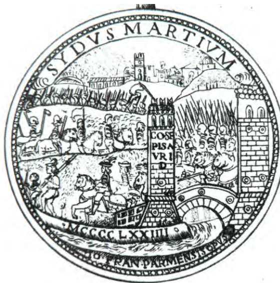
78. Ponte sul Foglia, medaglia di Gianfrancesco Enzola, 1474. Si notino le due torri scarpate con cannoniere e, su quella di destra, la provvista di palle di cannone. I militi con lance e archibugi, al comando di Costanzo, appena uscito dal ponte, a cavallo e con berretto piumato, salgono verso l'Imperiale di cui si vede, in lontananza, la torre.
