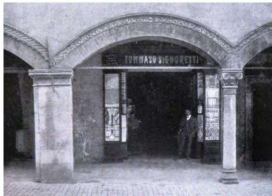
99. Via dei Fondachi, nella "piazzetta" palazzo quattrocentesco.
