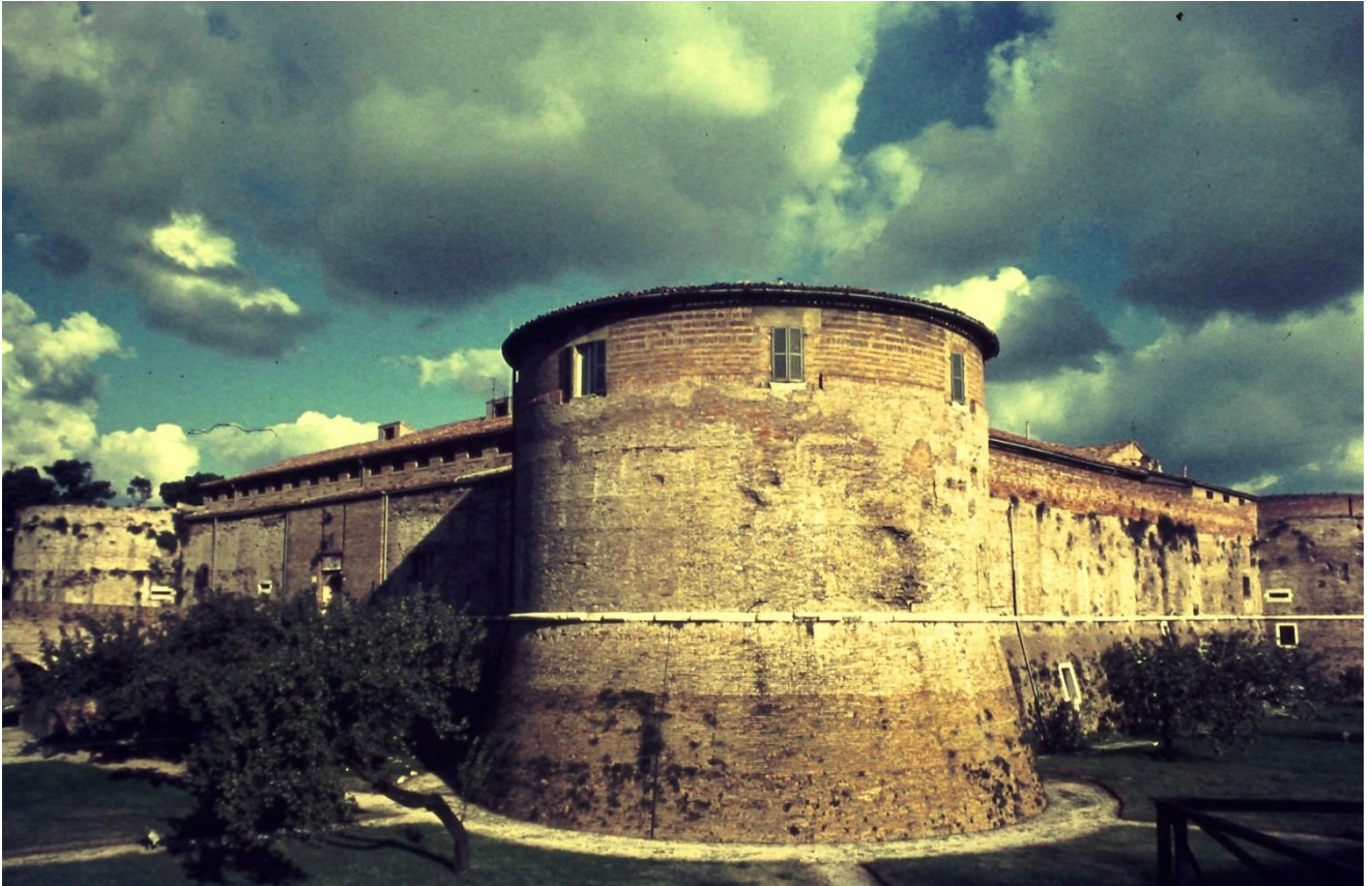
62. Rocca Costanza oggi, dopo le manomissioni dei beccatelli e della merlatura nel '6-700 e l'eliminazione della parte alta del maschio, forse per un crollo.
